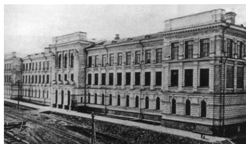
Строительство главного корпуса Томского политехнического
