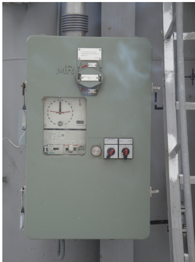
Рис. 2. Привод РПН
