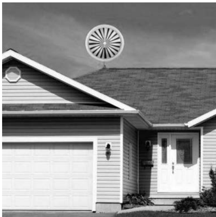
Рис. 3. Ветрогенератор на крыше дома
