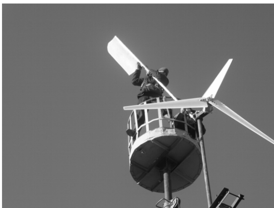
Рис. 1. Монтаж ВЭУ
