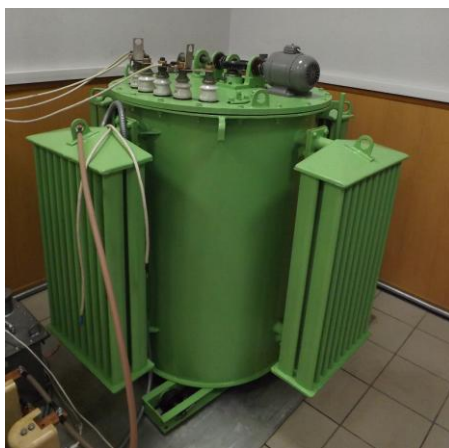
Рисунок 4.19 – Регулировочный трансформатор РОТМ-100/0,5
