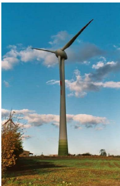
Рис. 1.2.2. Горизонтально-осевая трехлопастная ВЭУ
