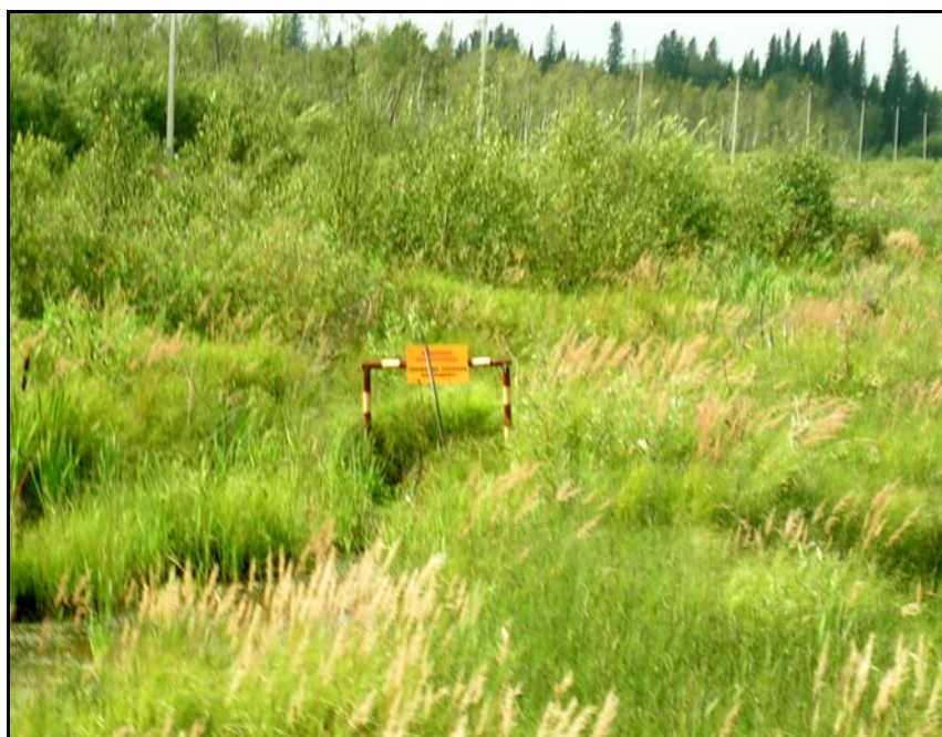
Рис. 5.10. Обозначение поворота трассы
