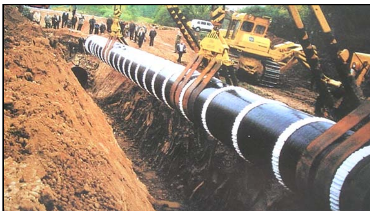
Рис. 1.38. Сооружение перехода под автодорогой
