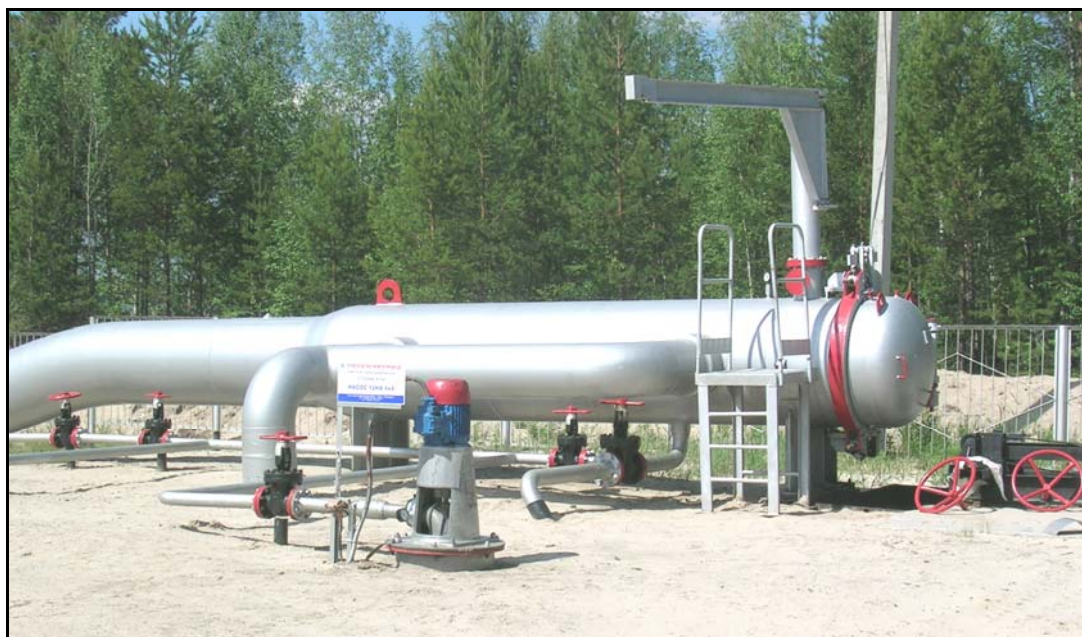
Рис. 5.15. Камера приема СОД
