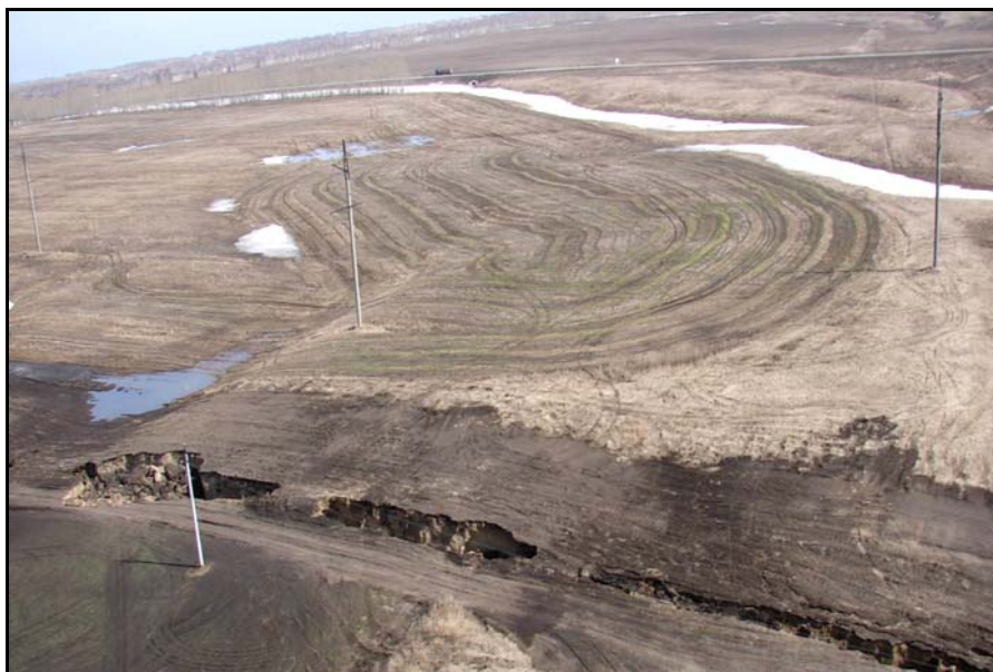
Рис. 5.5. Просадка грунта над трубопроводом в карстовых зонах
