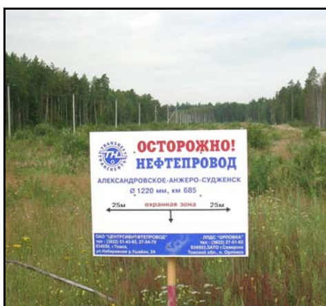
Рис. 5.11. Предупреждающие знаки на трассе магистрального нефтепровода и газопровода с указанием границ охранной зоны
