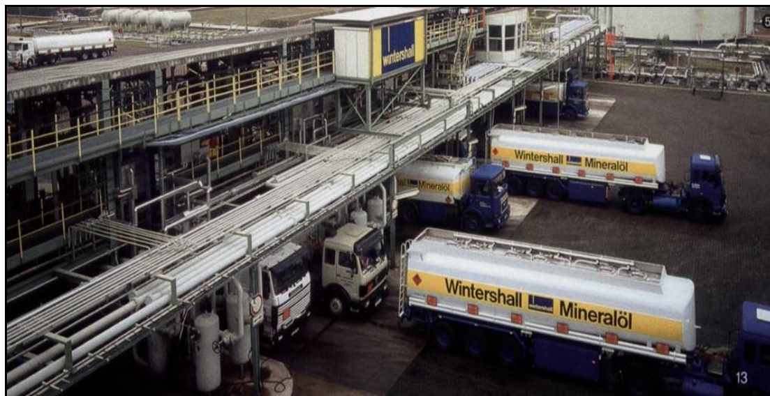
Рис. 1.18. Пункт налива в автомобильные цистерны
