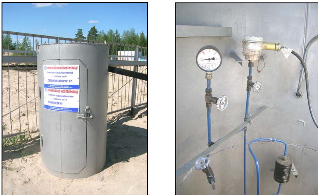
Рис. 5.12. Защитный ковер сигнализатора прохождения средств очистки и диагностики и узла отбора давления
