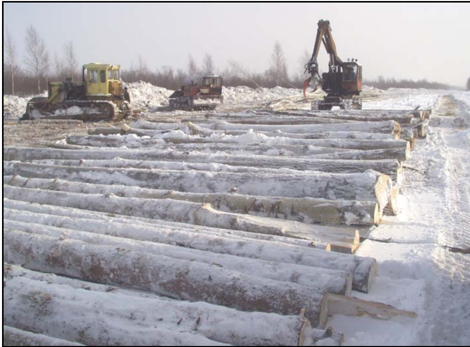
Рис. 5.22. Строительство лежневой дороги в зимнее время
