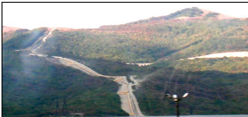
Рис. 1.33. Надземная прокладка газопровода с П-образными компенсаторами
