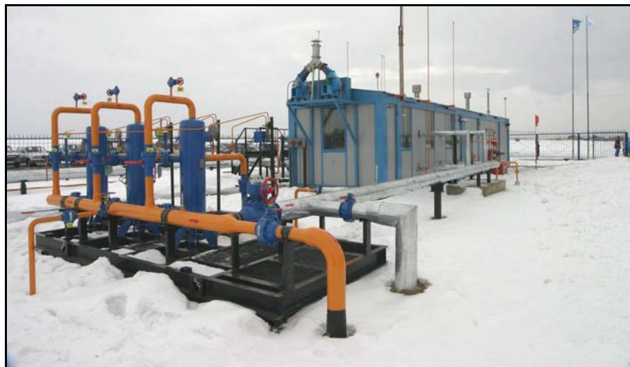
Рис. 1.22. Газораспределительная станция
