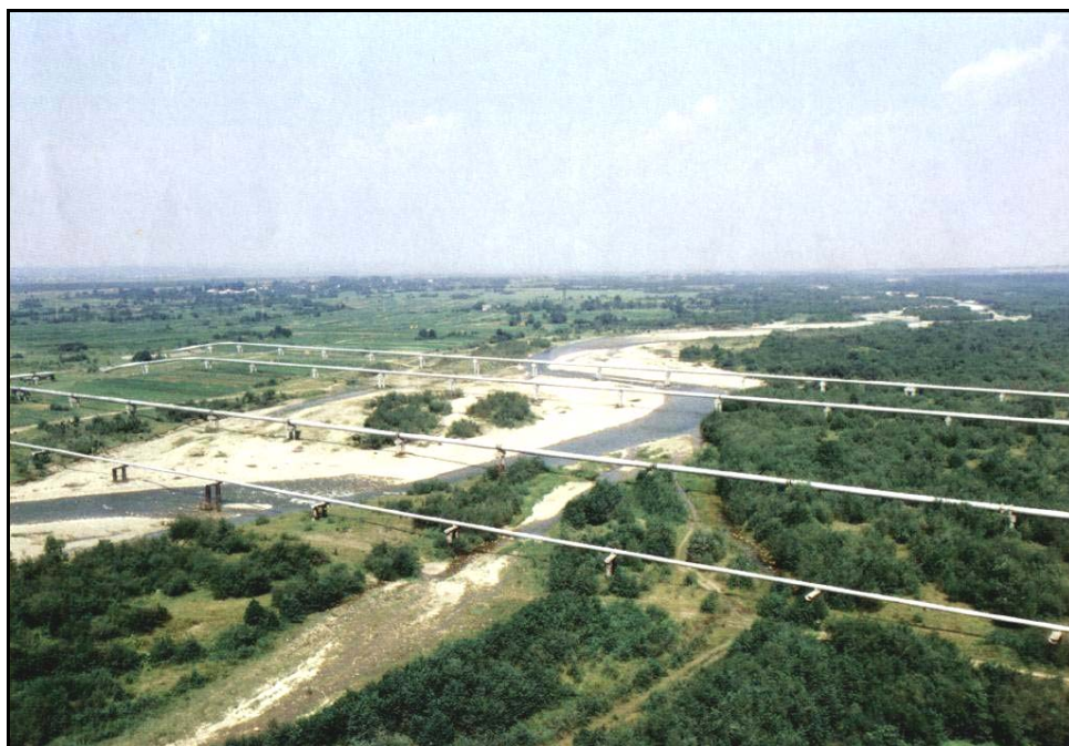
Рис. 5.19. Воздушный переход многониточного трубопровода через водную преграду
