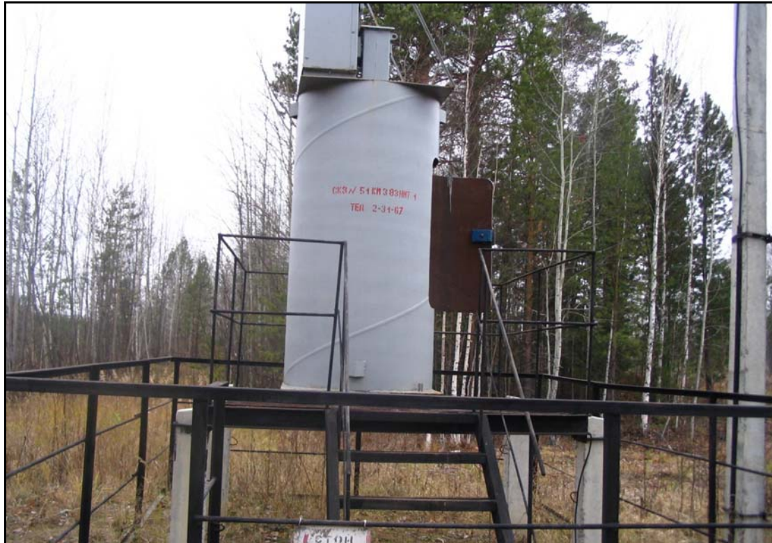
Рис. 1. 10. Установка электрохимической защиты трубопровода от коррозии (станция катодной защиты)
