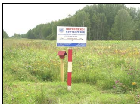
Рис. 5.9. Предупреждающие знаки на переходе через автомобильную дорогу
