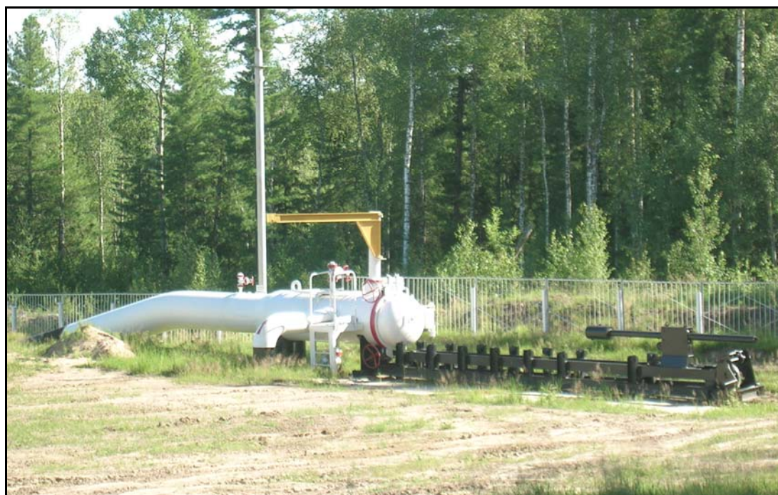
Рис. 5.16. Камера пуска СОД
