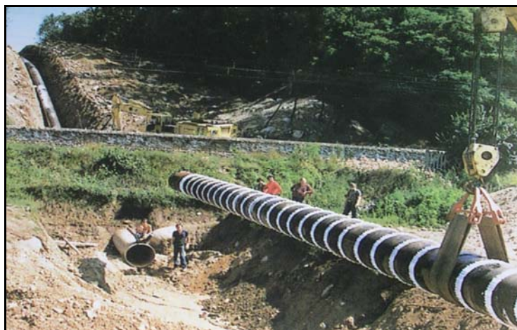
Рис. 1.37. Сооружение перехода трубопровода под железной дорогой
