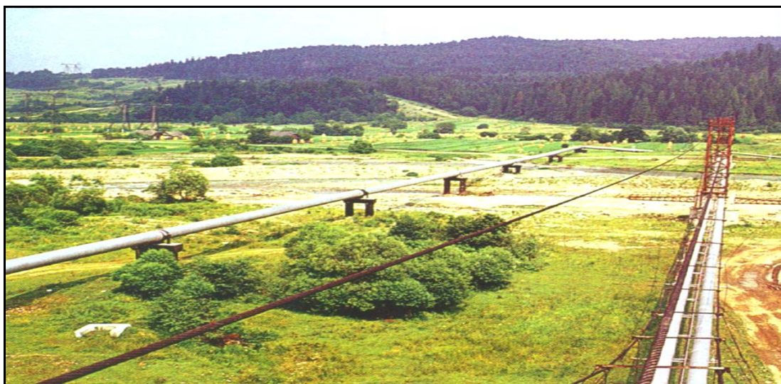
Рис. 1.36. Надземный (воздушный) переход трубопровода через водную преграду
