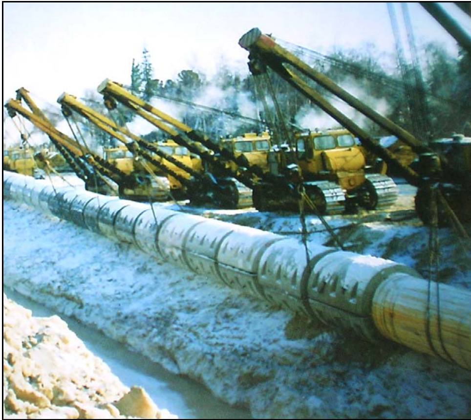
Рис. 2.4. Балластировка трубопровода кольцевыми железобетонными пригрузами
