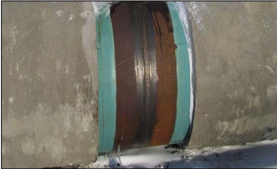
Рис. 1.7. Трубопровод с бетонным покрытием
