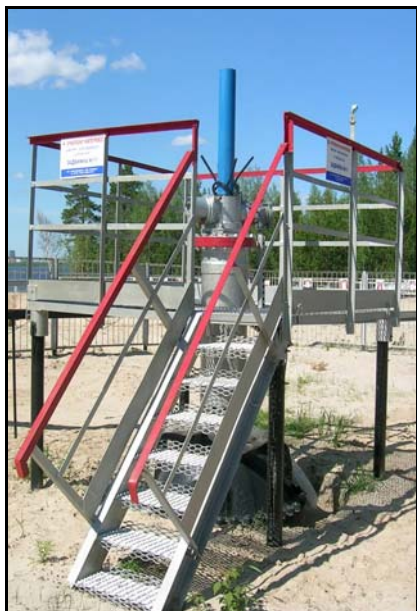
Рис. 1.14. Линейная запорная арматура
