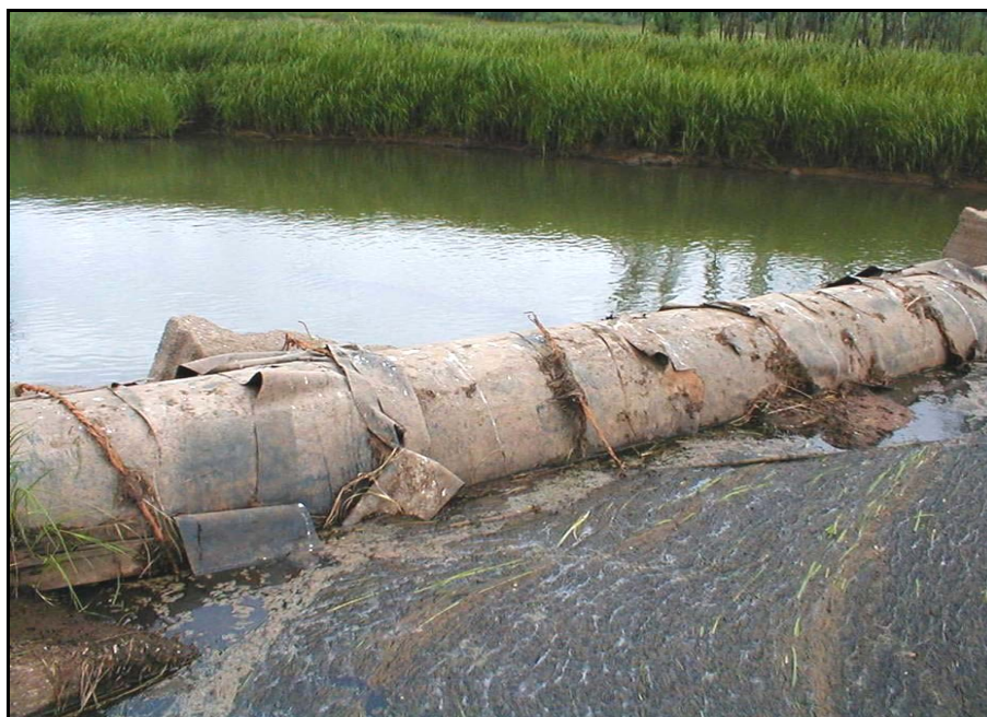
Рис. 5.6. Оголенный участок трубопровода, пересекающий водную преграду
