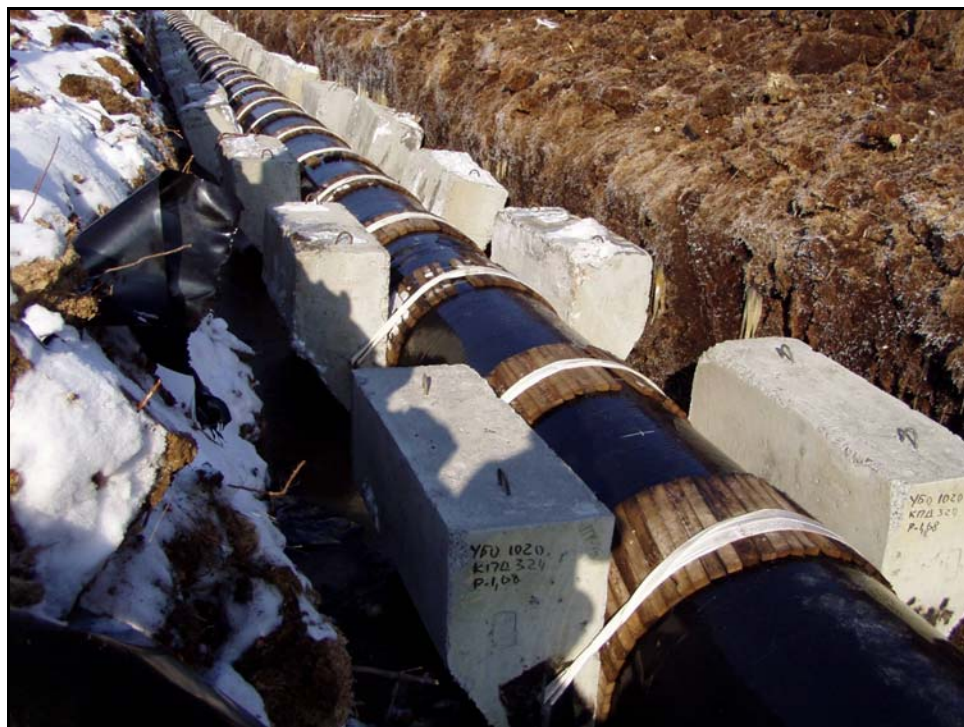
Рис. 2.5. Утяжелители охватывающие бетонные (УБО)
