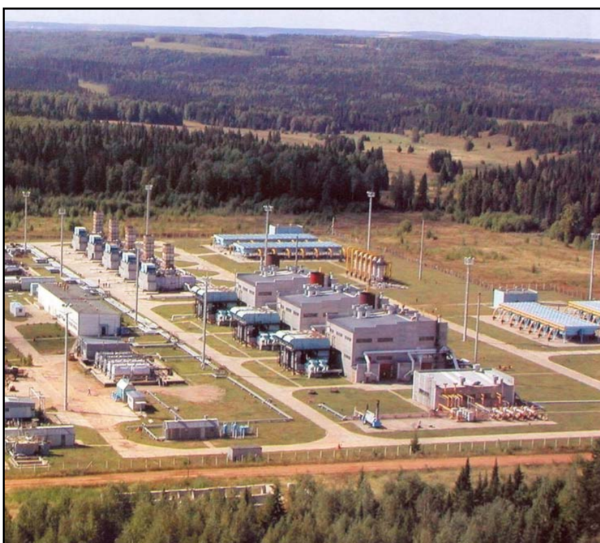
Рис. 1.21. Компрессорная станция магистрального газопровода
