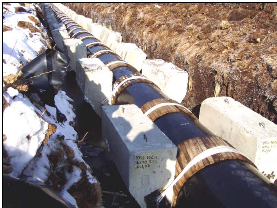
Рис. 1.28. Балластировка бетонными утяжелителями
