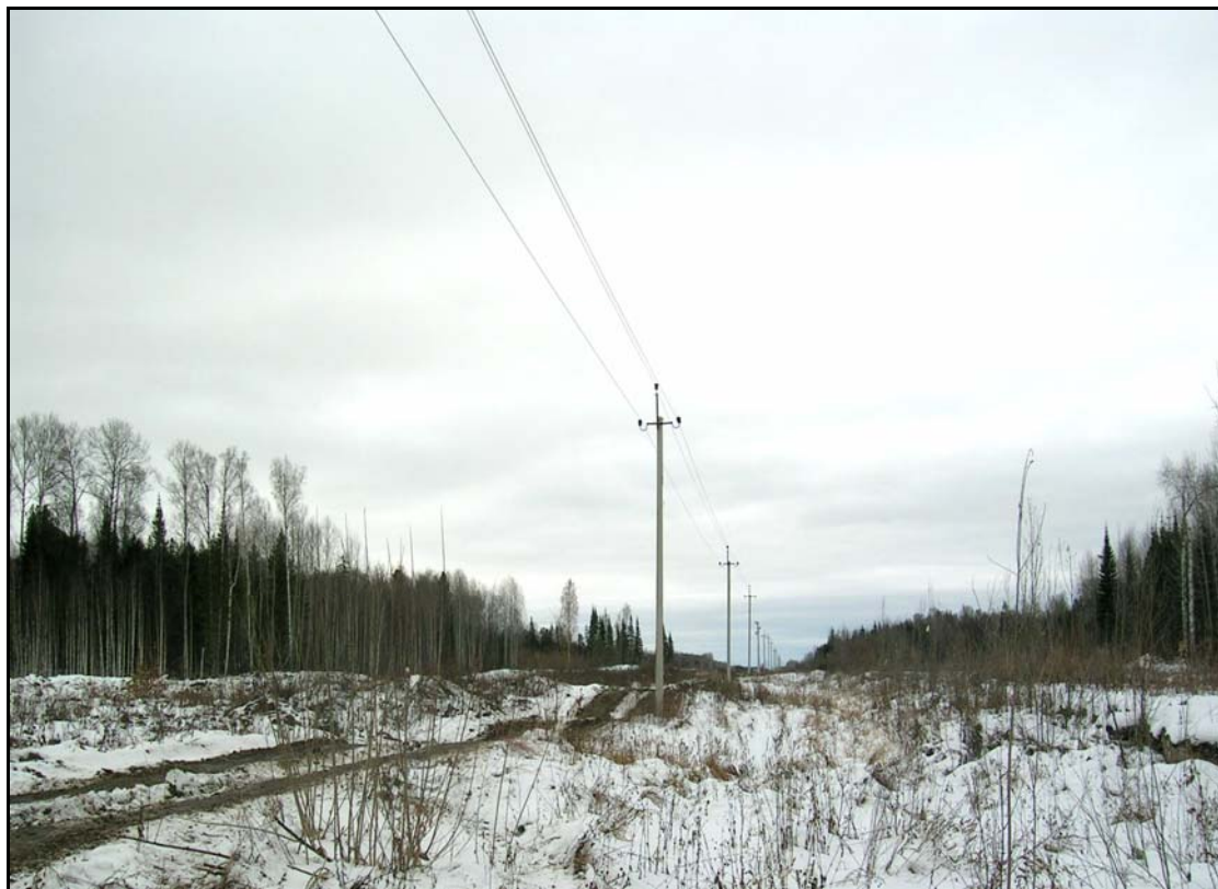
Рис. 1.11. Вдольтрассовая высоковольтная линия (ВЛ)
