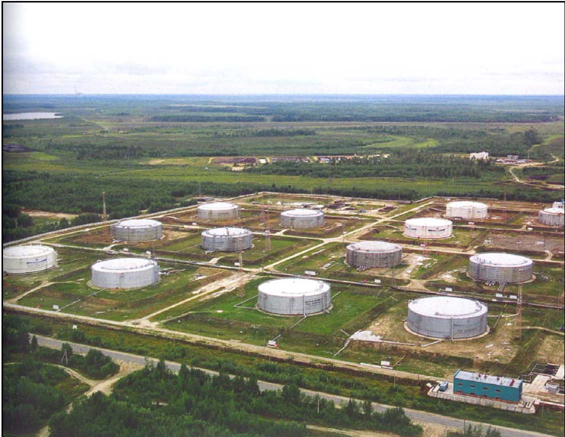
Рис. 1.16. Резервуарный парк головной нефтеперекачивающей станции
