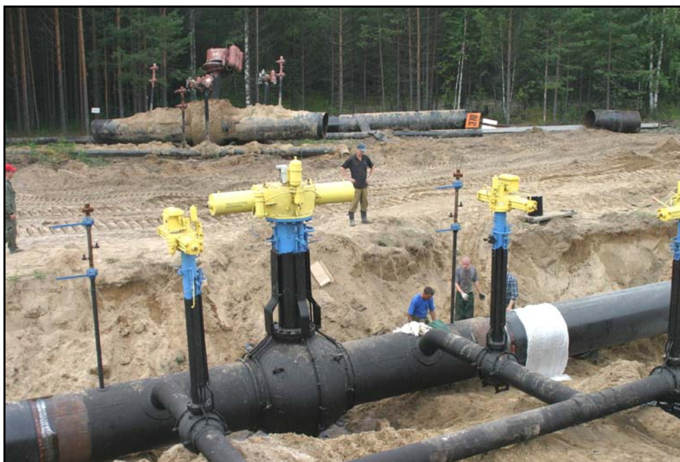
Рис. 1.25. Линейный крановый узел
