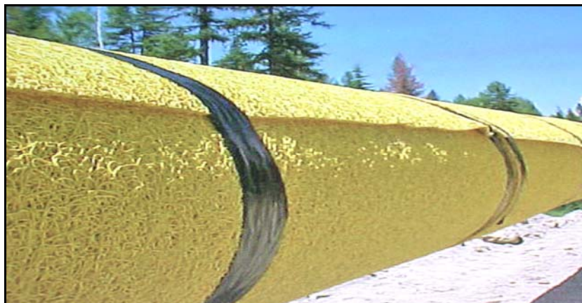
Рис. 1.29. Футеровочный мат для защиты изоляционного покрытия от повреждения
