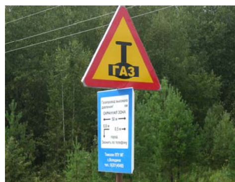
Рис. 5.9. Предупреждающие знаки на переходе через автомобильную дорогу
