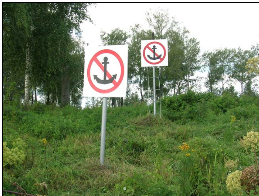
Рис. 5.20. Предупреждающие знаки на подводном переходе «якоря не бросать»
