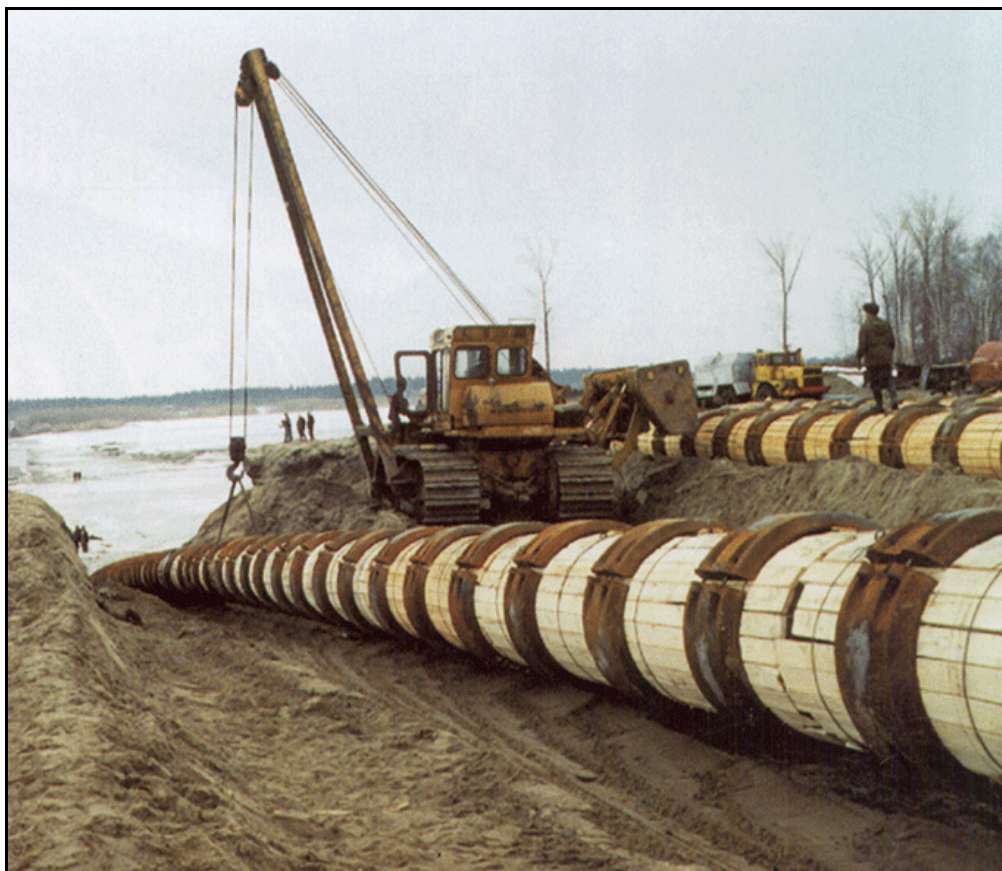
Рис. 2.3. Балластировка трубопровода кольцевыми чугунными пригрузами
