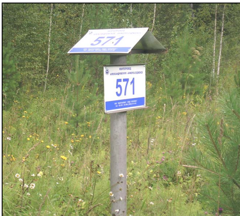
Рис. 5.8. Оповестительный знак магистрального трубопровода
