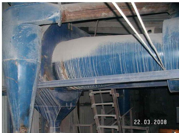
*Рис. 3.15. Фрагмент пылеуловителя системы аспирации короба пересыпки транспортеров дробленого известняка*
