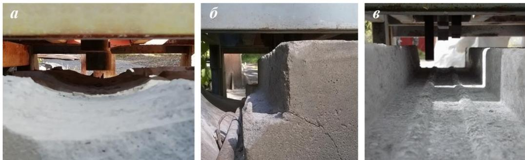
Рис. 2 Виды штрыбы, полученные при использовании молотков:
