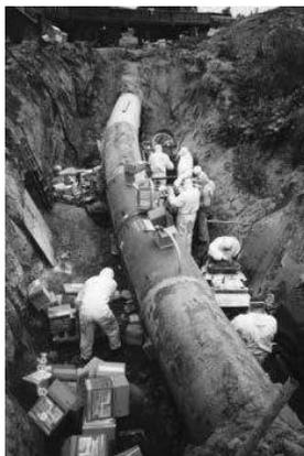
**Рис. 1. Установка муфты КМТ**
