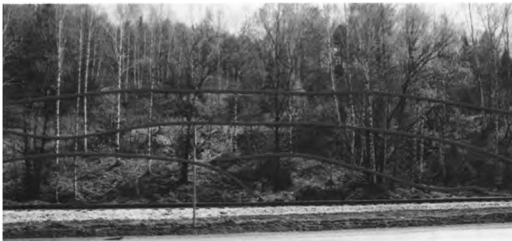
Рис.2 Оползневые террасы, ограниченные тыловыми швами и стенками отрыва
