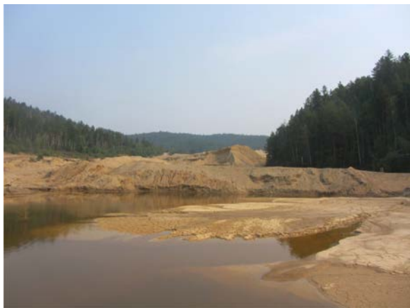
Рис. 1. Старый водоотстойник на территории действующего рудника месторождения вольфрама Бом-Горхон
