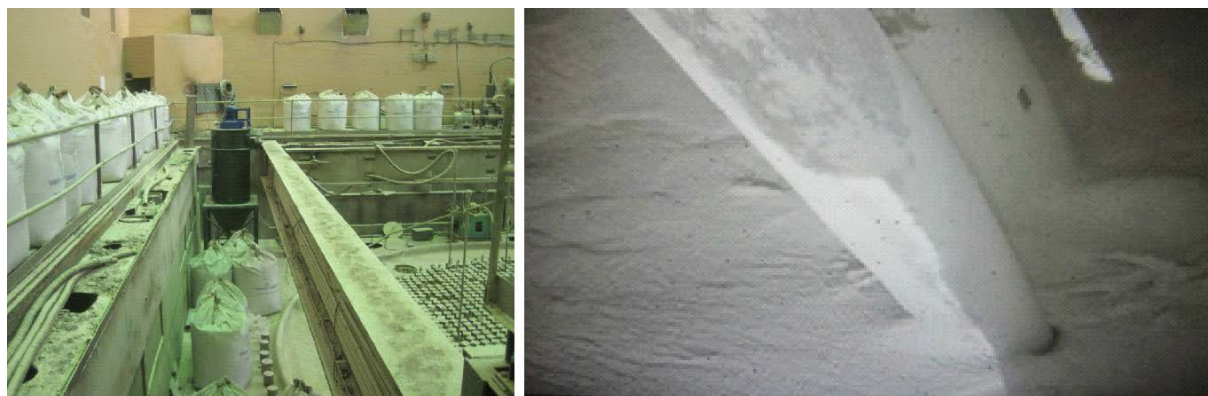
Рис. 4. Создание дополнительных барьеров безопасности в шахте ПУГР ЭИ-2 (вид в центральном зале – слева, барьерный материал в полостях шахты реактора – справа)
