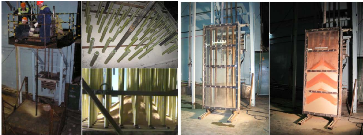
Рис. 2. Проведение макетных испытаний технологии бесполостного заполнения
