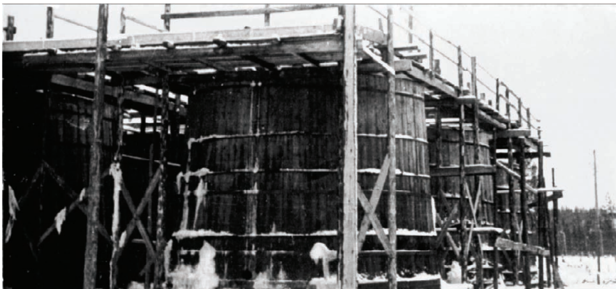
Рис. 1. Батарея отстойных чанов на заводе по переработке воды, 1930-е гг. (Коллекция автора).
