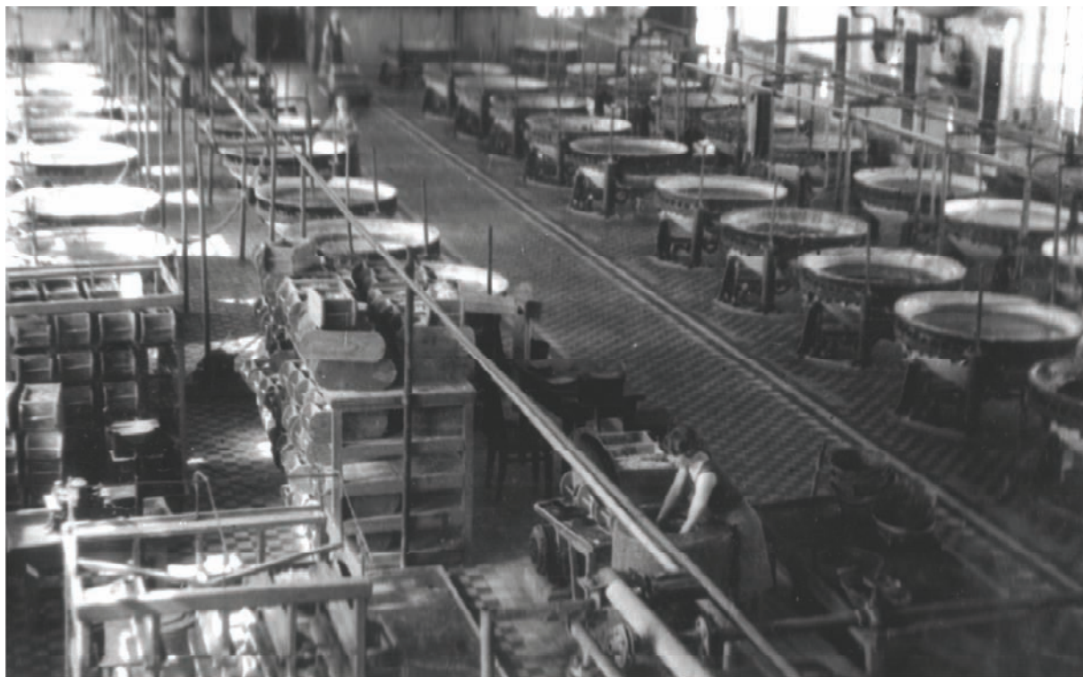
Рис. 3. Участок хлоридной кристаллизации завода по переработке радиевого концентрата, 1940-е гг. (Национальный государственный архив Республики Коми, фонд №3728, Коллекция фотодокументов, опись №1, дело №1611, рис. 88).
