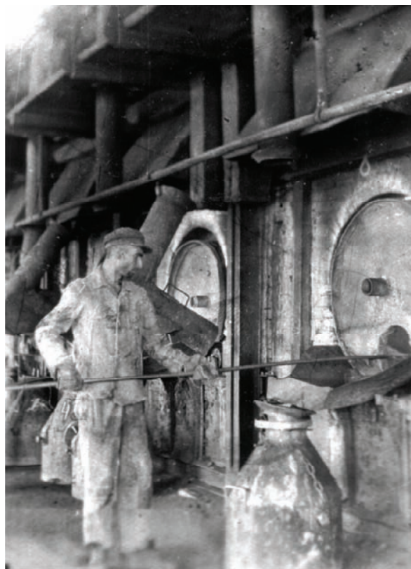
Рис. 2. Выгрузка спека из вращающихся муфельных печей, печной цех завода по переработке радиевого концентрата, 1940-е гг. (Национальный государственный архив Республики Коми, фонд №3728, Коллекция фотодокументов, опись №1, дело №1611, рис. 87).
