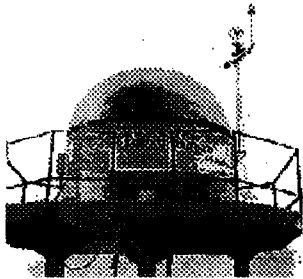
Рис.1. Установка АРЭС на платформе
