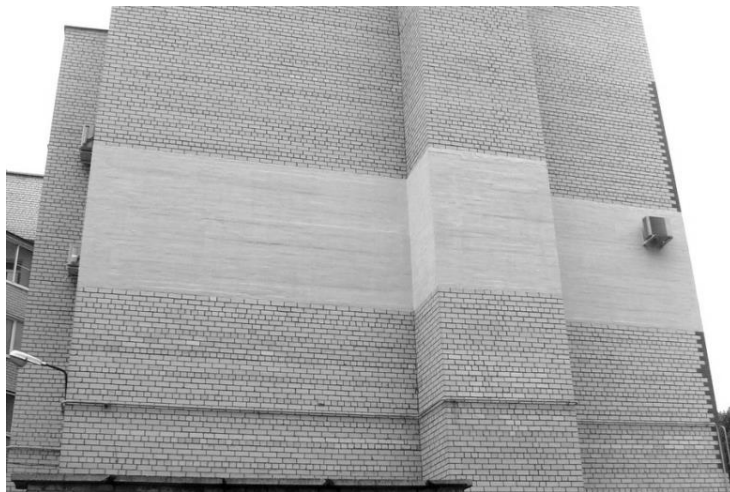
Рис. 1. Пример применения жидкого утеплителя
