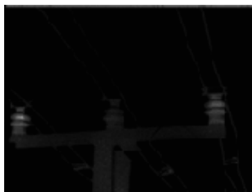
Рис. 6. Повышение температуры опорных изоляторов
