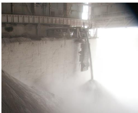
Рис.2. Выделение пыли при ссыпании материала из конвейера в склад.
