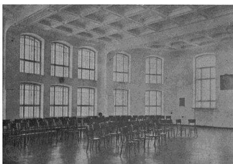
Рис. 3. Первоначальный вид помещения лекционной аудитории. 1912 г.
