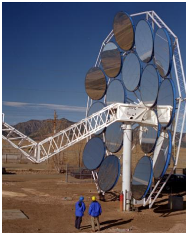
Рис. 4.10 СЭС с концентраторами тарельчатого типа
