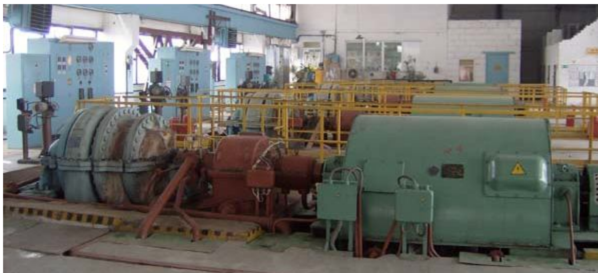
Рис. 2.13. Компрессорная станция: турбокомпрессор К-250; соединительная муфта и электродвигатель
