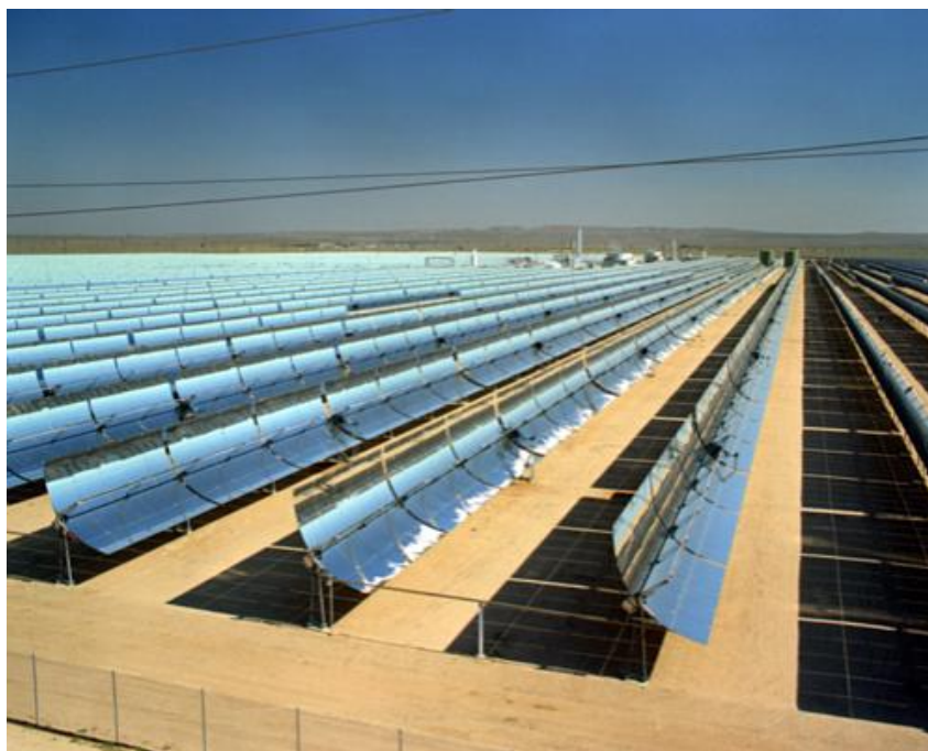
Рис. 4.9 СЭС с параболическими концентраторами
