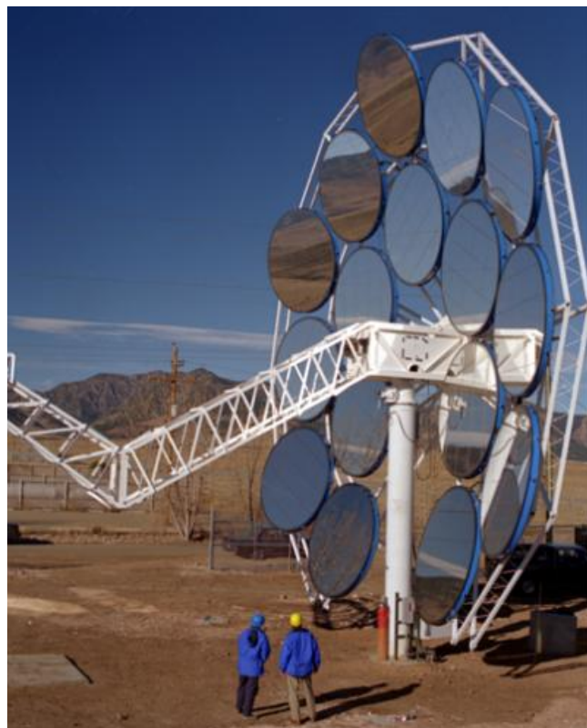
Рис. 4.10 СЭС с концентраторами тарельчатого типа
