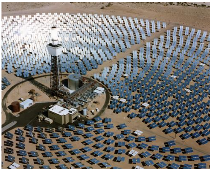
Рис. 4.8 СЭС башенного типа
