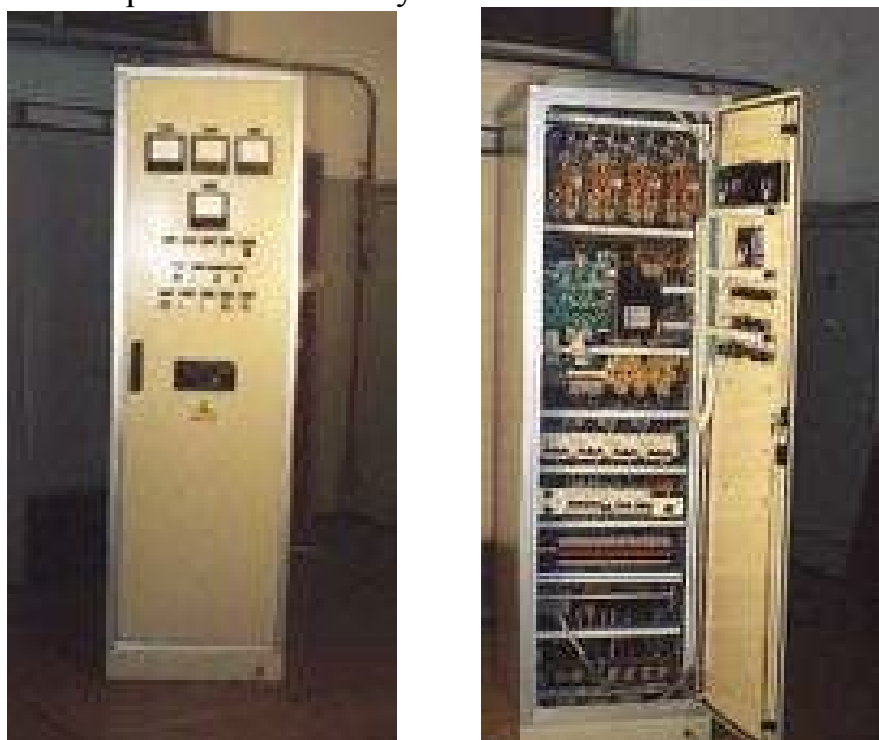
Рис. 3.22. Конструктивное выполнение систем возбуждения турбогенераторов
