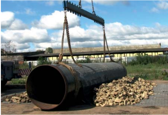
Рис. 1. Подготовленный испытательный стенд технического решения по стабилизации трубопровода
