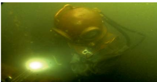
Рис. 4. Мокрая сварка
