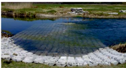
Рис. 2. Гибкие бетонные маты
