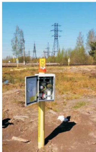
Рис. 3. Устройство защиты трубопровода от воздействия наведенного переменного тока
