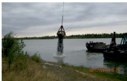
Рис. 1. Каменная отсыпка
