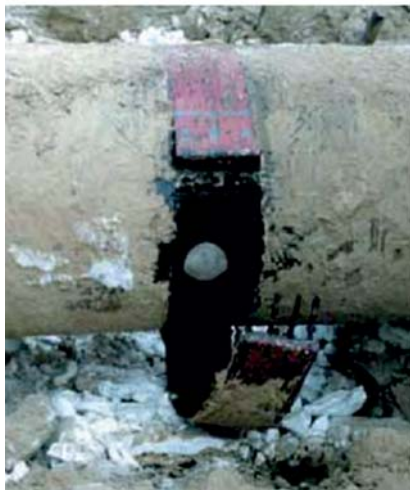
Рис. 4. Демонтаж муфты РСМ
