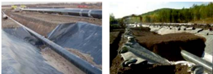
Рис. 2. Водонепроницаемые траншеи
