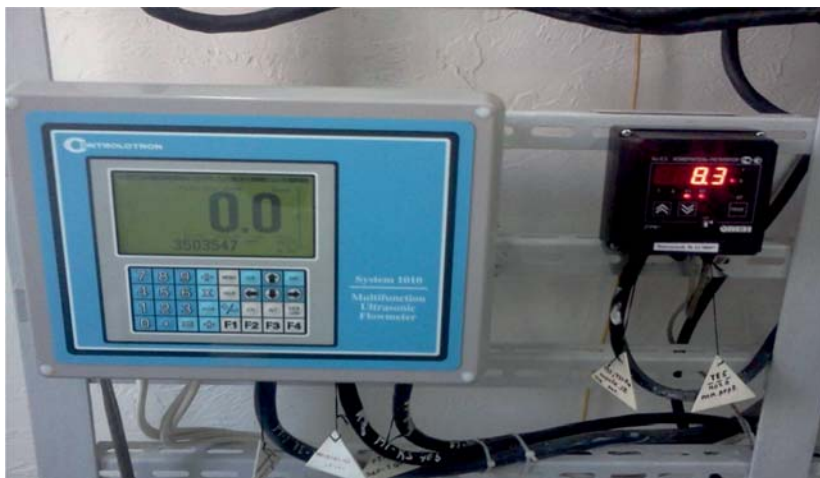
Рис. 2. Ультразвуковой расходомер Controlotron
