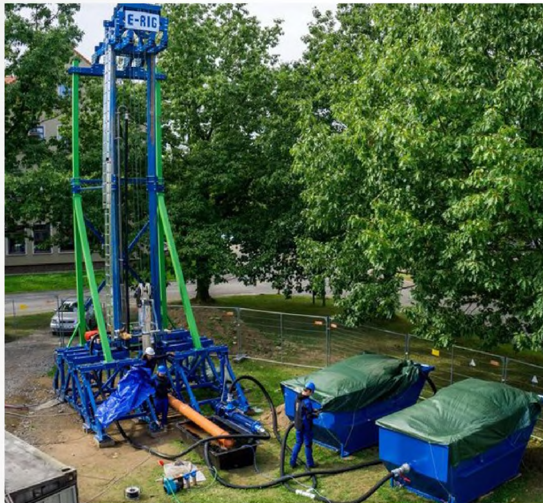
Буровая установка ЭИБ
