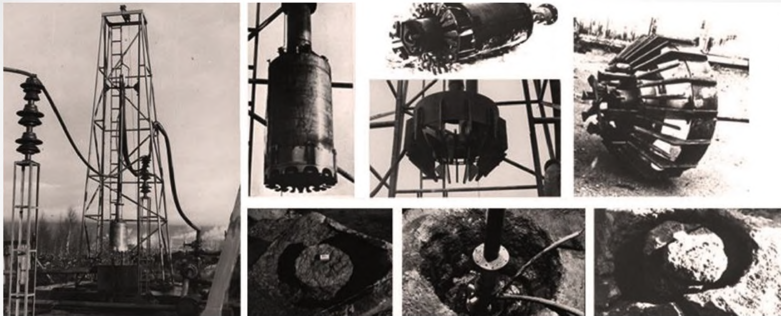
Высоковольтный полигон электроимпульсного бурения КНЦ РАН
