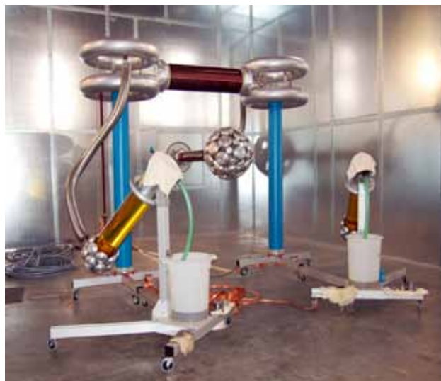
Рис.1.9 – Экранированная лаборатория HIGH VOLT для испытаний высоковольтных кабелей
