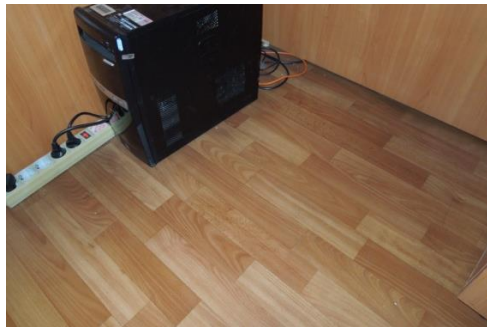
Под рабочим столом отсутствует мусор, грязь. Провода уложены и не создают помех пользователю
