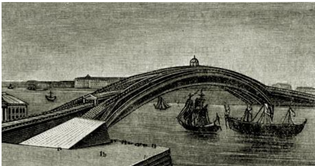
Проект деревянного моста через р. Неву, составленный И. П. Кулибиным в 1776 г.
