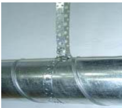
Рис. 5.14. Крепление газохода:
