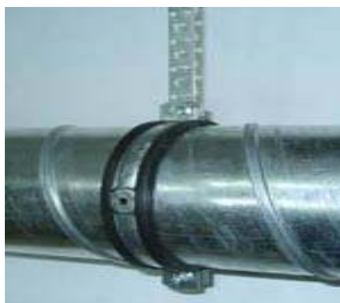
Рис. 5.14. Крепление газохода:
