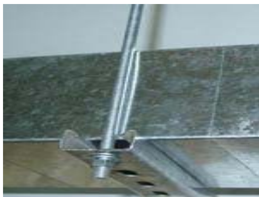
Рис. 5.12. Крепление воздуховодов:
