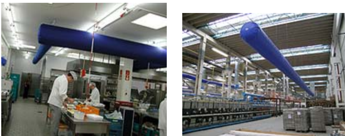
Рис. 4.2. Варианты установки текстильных воздуховодов ( www.bazaovk.ru )
