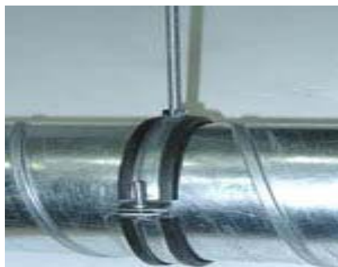
Рис. 5.12. Крепление воздуховодов:
