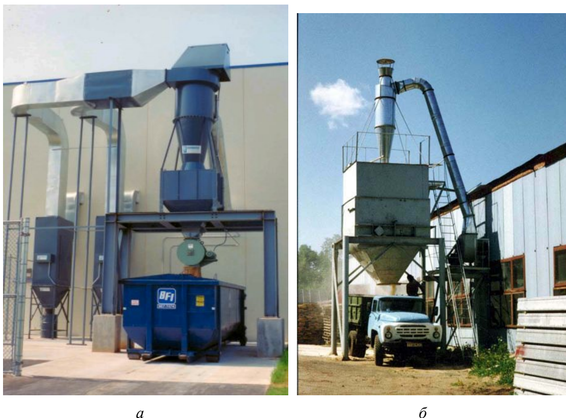
Рис. 3.109. Выгрузка пыли: a – с помощью роторного лопастного затвора; б – с помощью шибера
