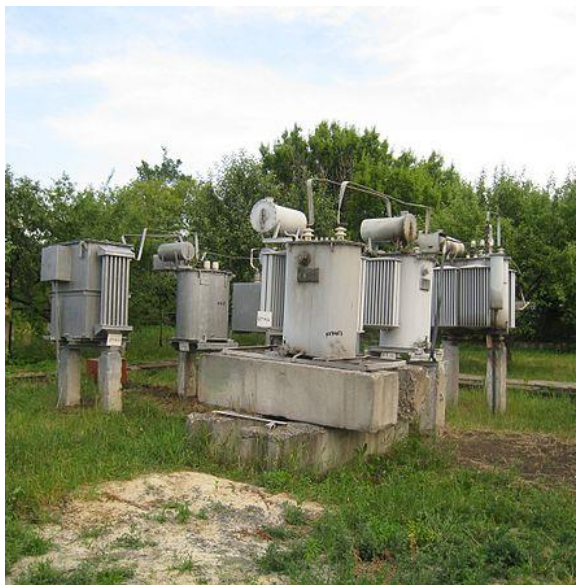
Дугогасящий реактор на подстанции
