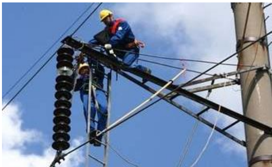
Старение и разрушение изоляторов
