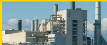
Комплекс по производству 500 тыс. тонн полипропилена в Тобольске
