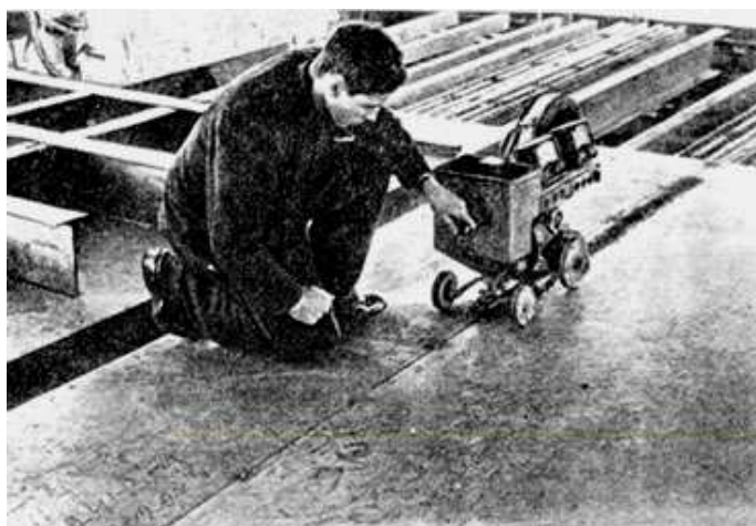
Рис. 2.17. Автоматическая сварка под флюсом плоскостных конструкций трактором ТС-17
