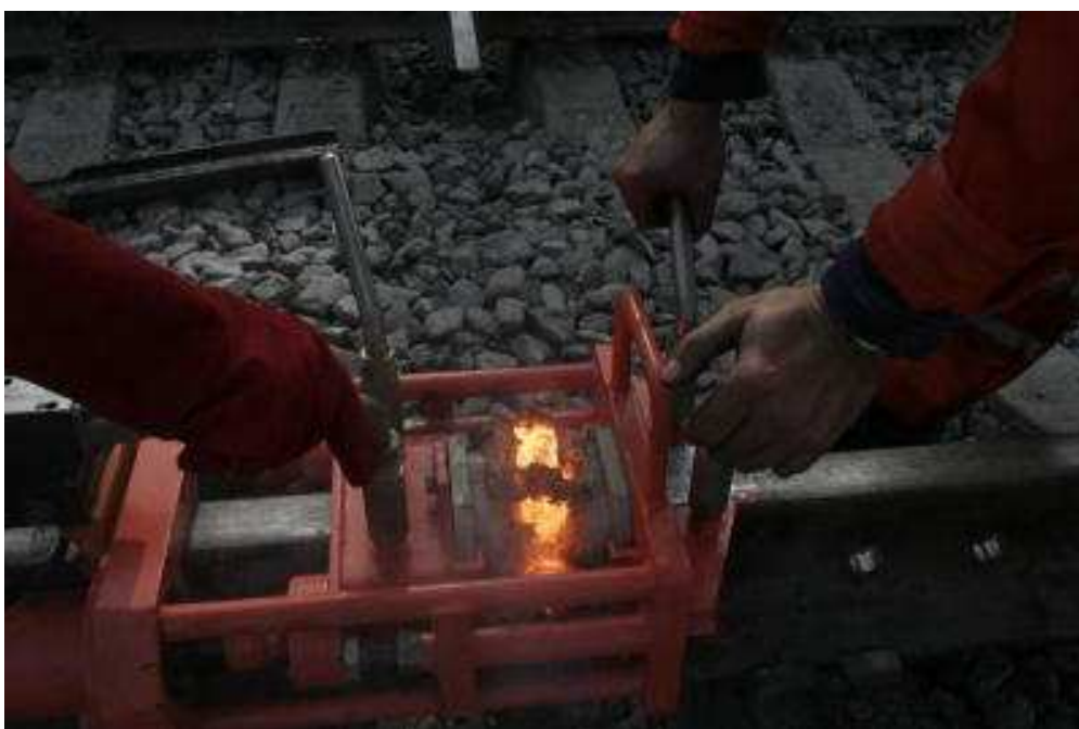
Рис. 4.2. Термитная сварка железнодорожного рельса
