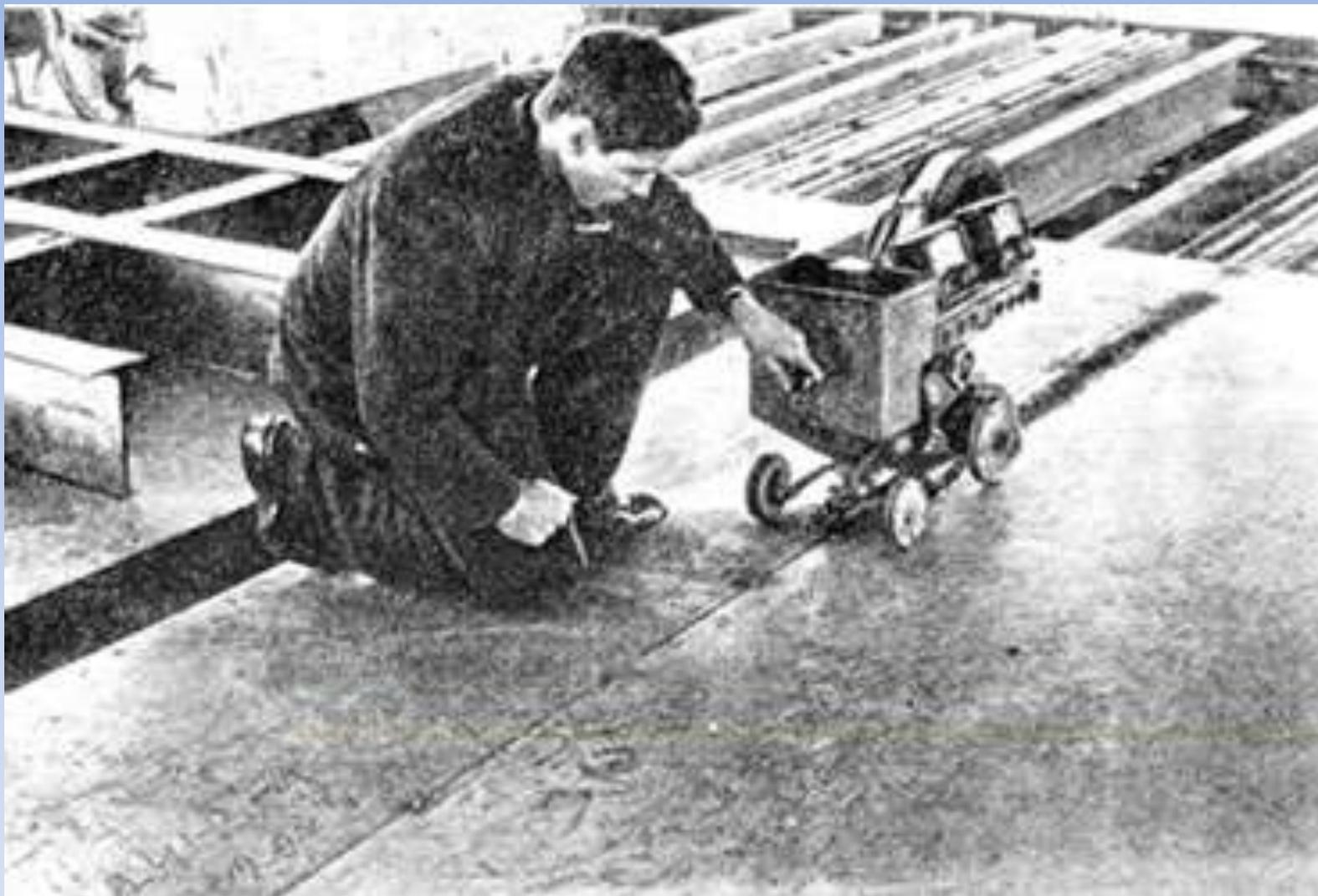
**Автоматическая сварка под флюсом плоскостных конструкций трактором ТС-17**
