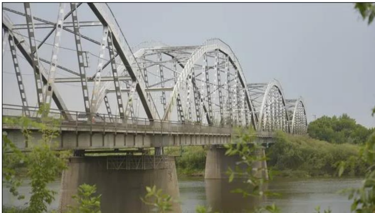
Фото 1.4. Автодорожный мост через Ишим, его всего два года назад (в 1961 году) сдали в эксплуатацию, но фото не наше, где-то 2020-х годов.
