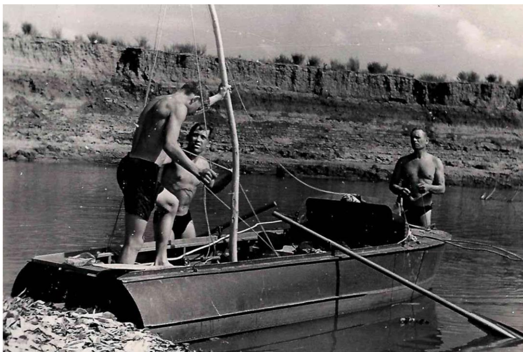
Фото 3.10. Устанавливаем новую мачту.
