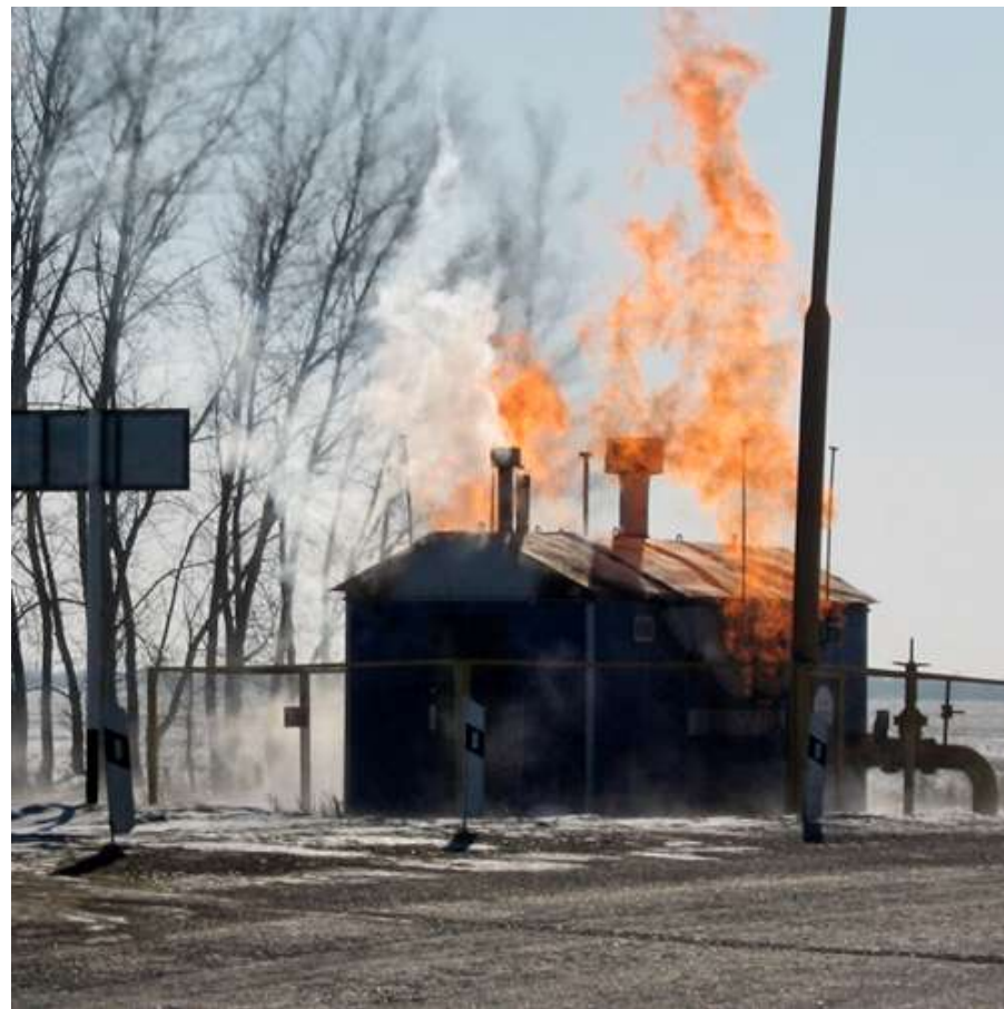
Прорыв газопровода в Омской области
