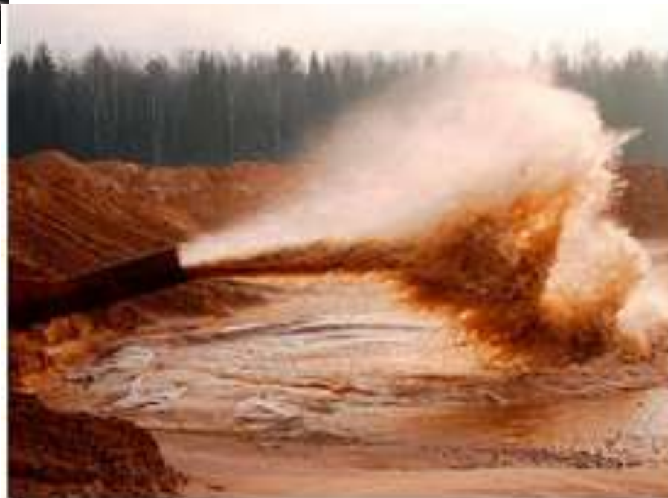
Смесь из воды и песка помещается в гидроотвалы
