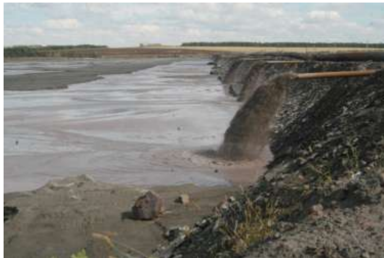
Береговая часть хвостохранилища Стойленского ГОКа
