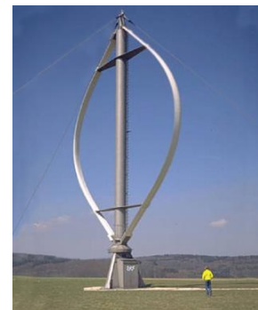
Ортогональный (ротор Дарье)
