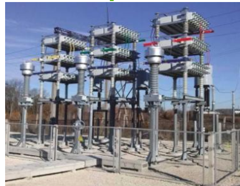
БСК-110-52 УХЛ1 – батарея статических конденсаторов, номинальным напряжением 110 кВ, номинальной мощностью – 52 МВАр
