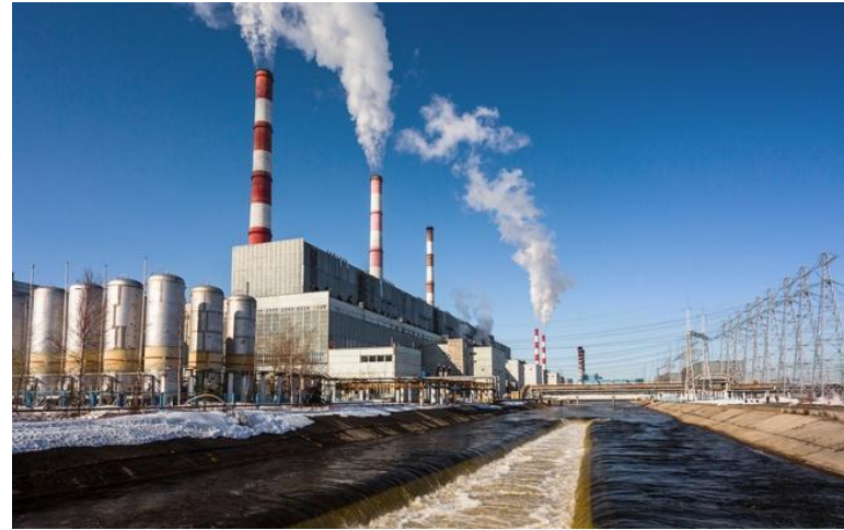
Искусственный водоем на Сургутской ГРЭС-2
