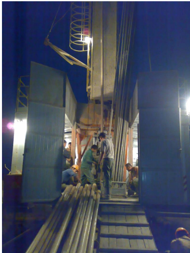
Спуск обсадной колонны
