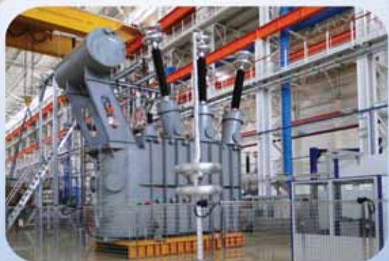
Силовой трехфазный трансформатор 63 МВА 220 кВ
