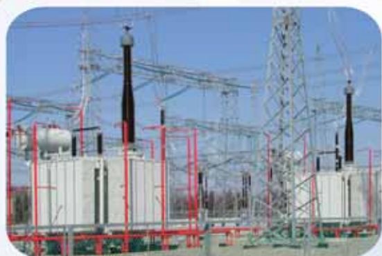
Шунтирующие реакторы 110 МВАр 750 кВ
