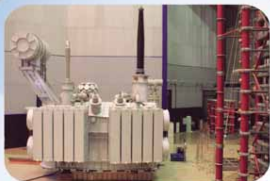
Однофазный автотрансформатор 267 МВА 500 кВ
