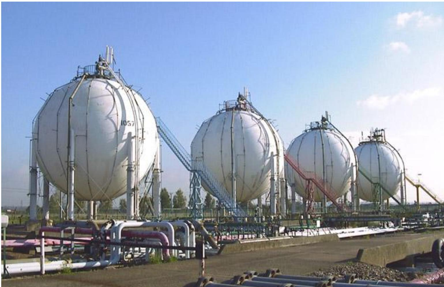
Газгольдер – резервуар (цилиндрический или сферический) для хранения газообразных веществ (природный газ, биогаз, сжиженный нефтяной газ, воздух)
