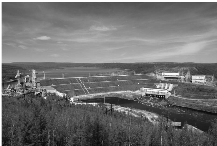
Рис. 2.3. Панорама Вилуйской ГЭС-1, 2 приплотинного типа
