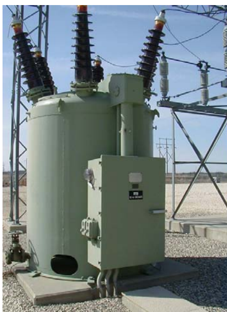
Рис. 4.4. Баковый высоковольтный масляный выключатель
