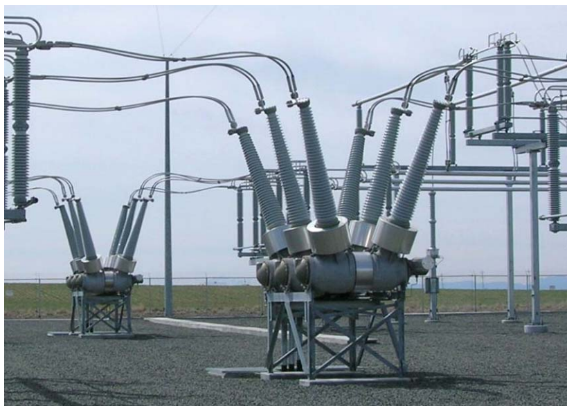
Рис. 4.7. Элегазовый выключатель высокого напряжения
