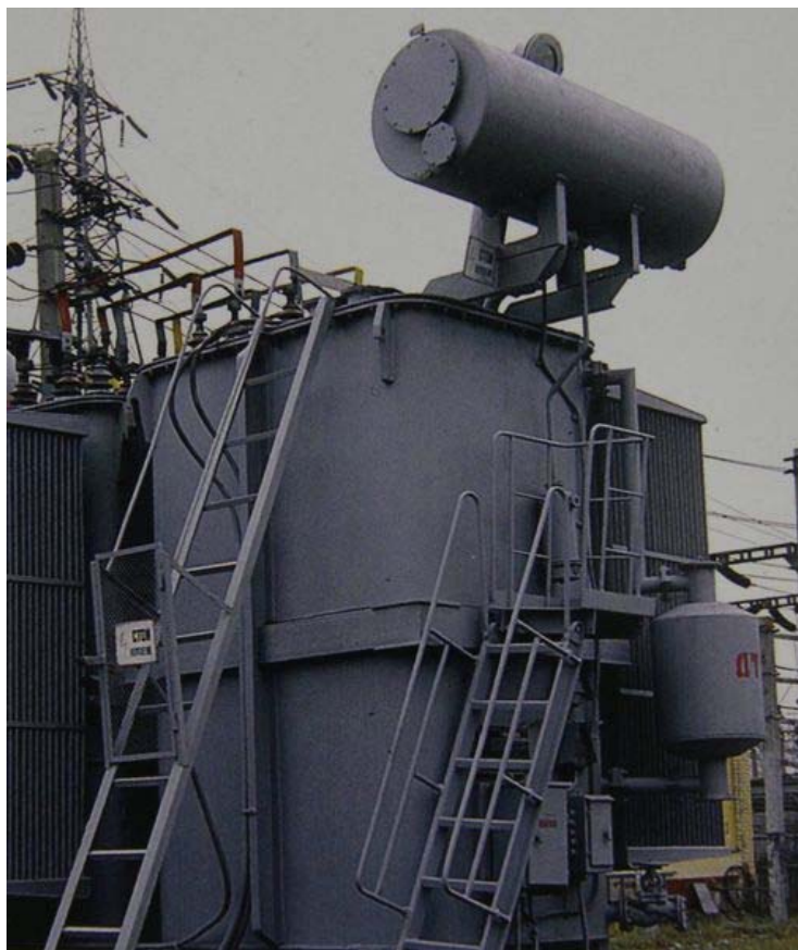
Рис. 4.10. Масляный реактор
