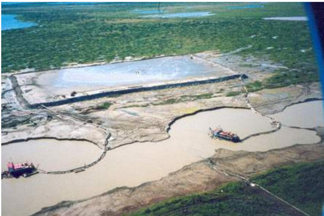
Рис. 16. Внешний вид намывного кустового основания
