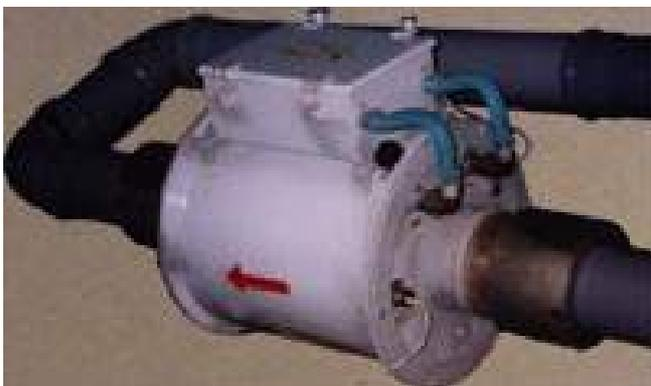
*Рис.160. Электромагнитный датчик расхода*
