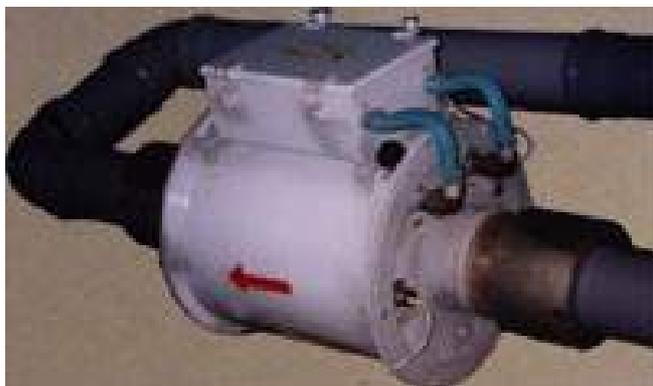
*Рис.160. Электромагнитный датчик расхода*
