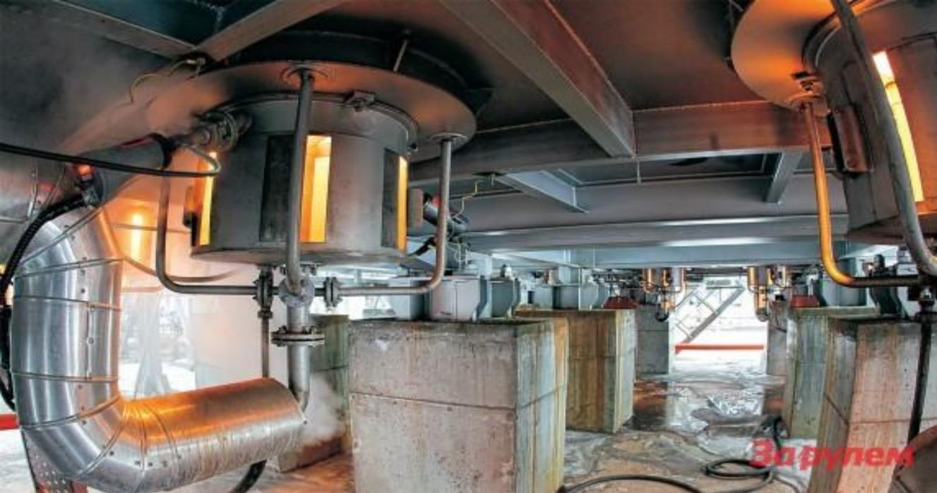
Подготовленная на входе НПЗ нефть (сырье) поступает на переработку на атмосферно-вакуумную трубчатку (АВТ), на которой происходит разделение нефти на фракции с разными температурами кипения. Используемый метод – многократное испарение и конденсация.
