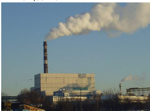
Рис. 5.6. Рассеивание выбросов с помощью дымовых труб
