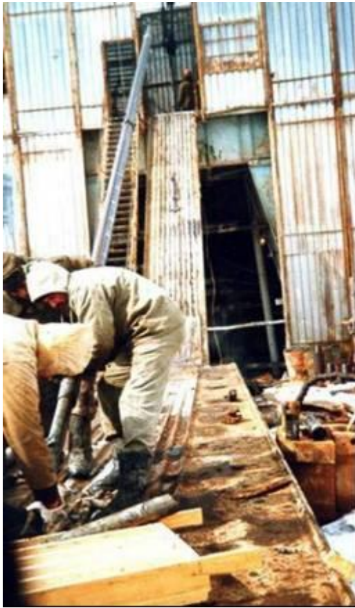
Рис. 2.2. Процесс извлечения колонки ориентированного керна
