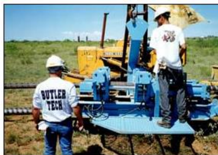
Рис. 2.16. Рабочий агрегат, подвешенный на стрелу трубоукладчика [14]
