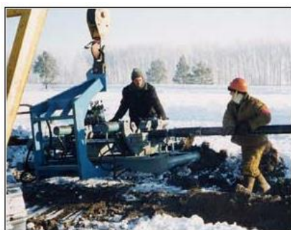
Рис. 2.15. Общий вид установки для механического соединения труб [14]
