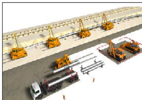
Рис. 2.17. Укладка трубопровода в траншею с помощью трубоукладчиков [7]
