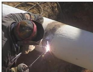
Рис. 1.17. Неразъемные соединения промышленных трубопроводов: а) ручная дуговая сварка; б) склеивание промышленных трубопроводов
