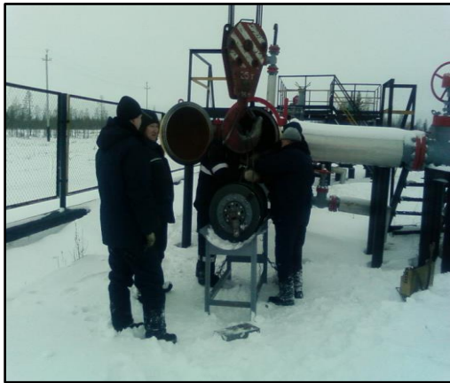
Рис. 5.15 Камера запуска очистного устройства
