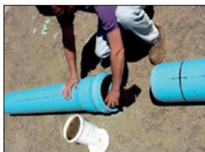
Рис. 1.17. Неразъемные соединения промышленных трубопроводов: а) ручная дуговая сварка; б) склеивание промышленных трубопроводов
