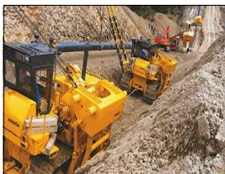
Рис. 1.1. Подземная прокладка промышленного трубопровода: а) в горной местности; б) на равнинной местности
