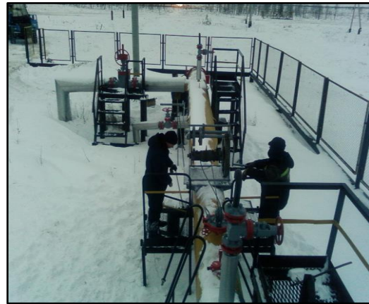
Рис. 5.15 Камера запуска очистного устройства
