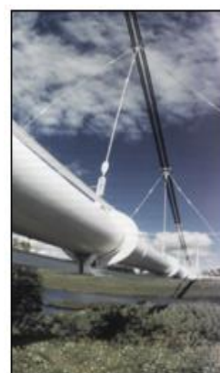
Рис. 1.10. Надземная прокладка трубопровода
