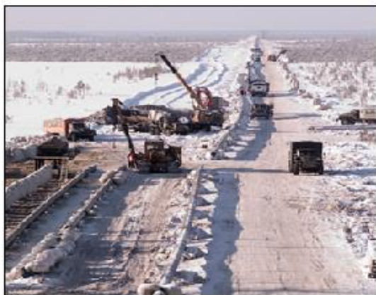
Рис. 1.9. Надземный способ прокладки промыслового трубопровода
