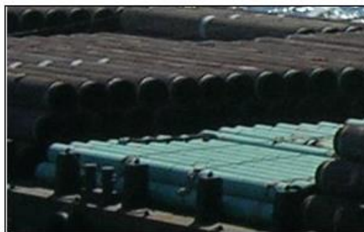
Рис. 2.6. Складирование труб на подготовленной площадке
