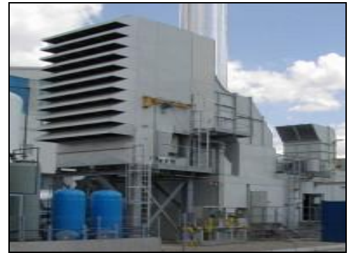
Рис.2.7. Комплексные воздухоочистительные устройства для газовых турбин блоков ПГУ-450 ст.№3 ТЭЦ-27 и ст.№11 ТЭЦ-21 ОАО "Мосэнерго"
