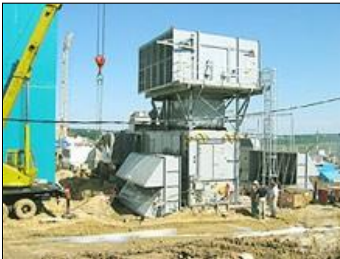
Монтаж системы воздухоочистки ГТУ-ТЭЦ «Луч» (данные ИА «Бел.Ру», 16.04.2009г.)
