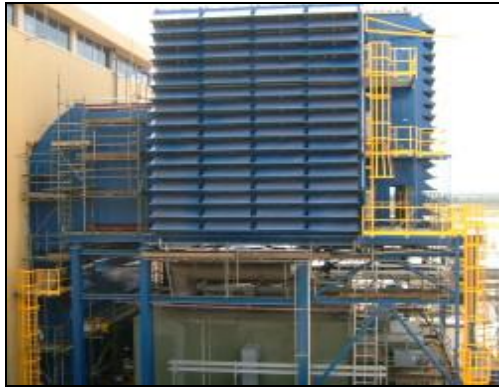
Рис.2.7. Комплексные воздухоочистительные устройства для газовых турбин блоков ПГУ-450 ст.№3 ТЭЦ-27 и ст.№11 ТЭЦ-21 ОАО "Мосэнерго"
