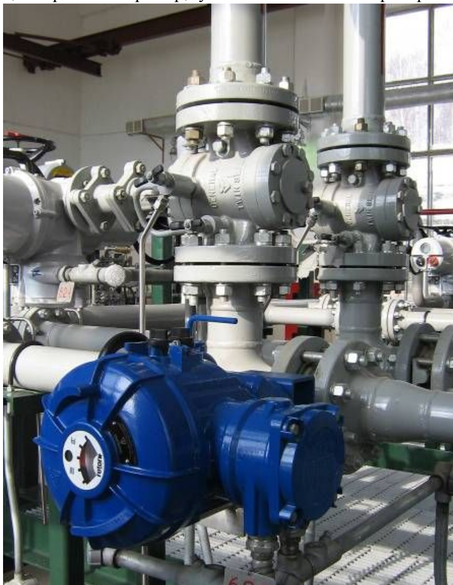
Рис. 4.19. Регулирующий клапан расхода типа FCV
