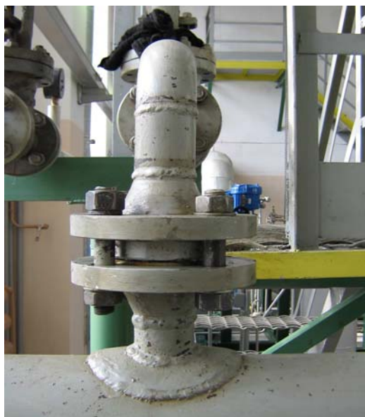
Рис. 3.9. Пробозаборное устройство целевого типа
