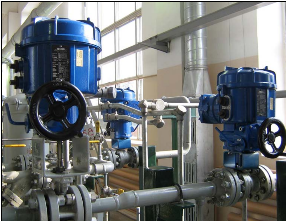
Рис. 3.39. Регулятор расхода, выходная задвижка БИК
